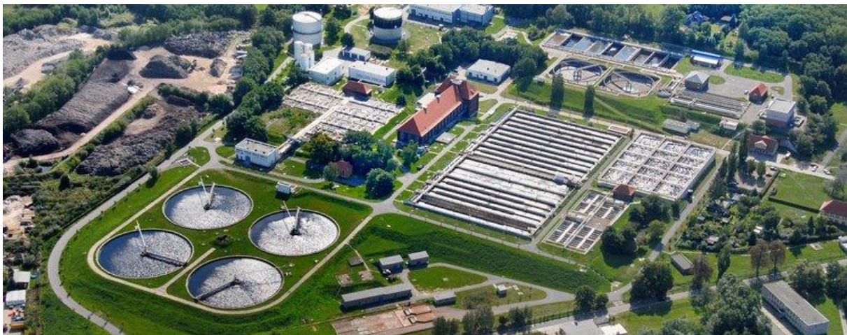
Das neue Klärwerk soll gegenüber des alten entstehen (Archivbild vom 13.09. 2008). Foto: Lutz Hannemann
