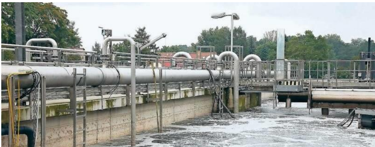
Im Umbau. Die Kläranlage im Norden wird erweitert, gestern gab es den ersten Spatenstich. Foto: Martin Müller
